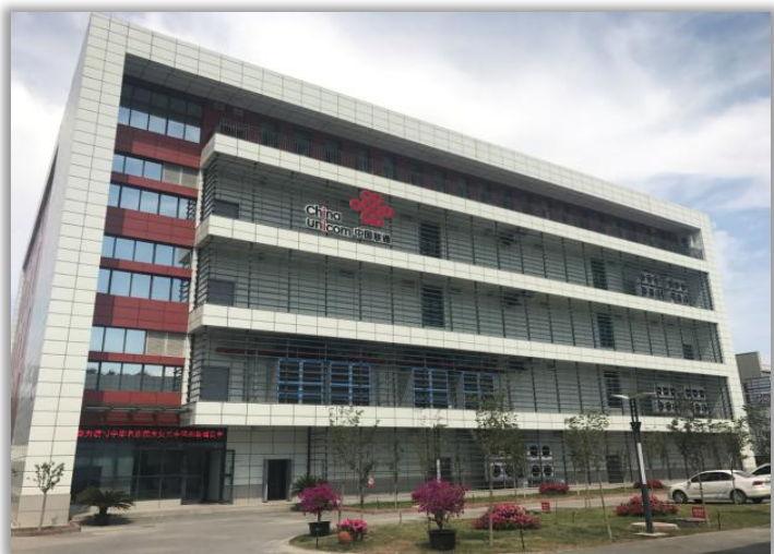
疆乌鲁木齐市某机房
