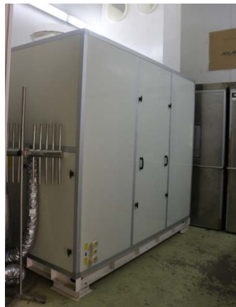
蒸发冷却冷水机组 (表冷+露点(叉流)+填料塔)
