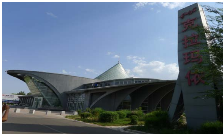
甘肃敦煌机场某航站楼
