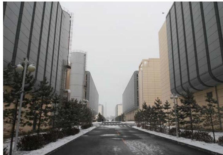
内蒙古某数据中心
