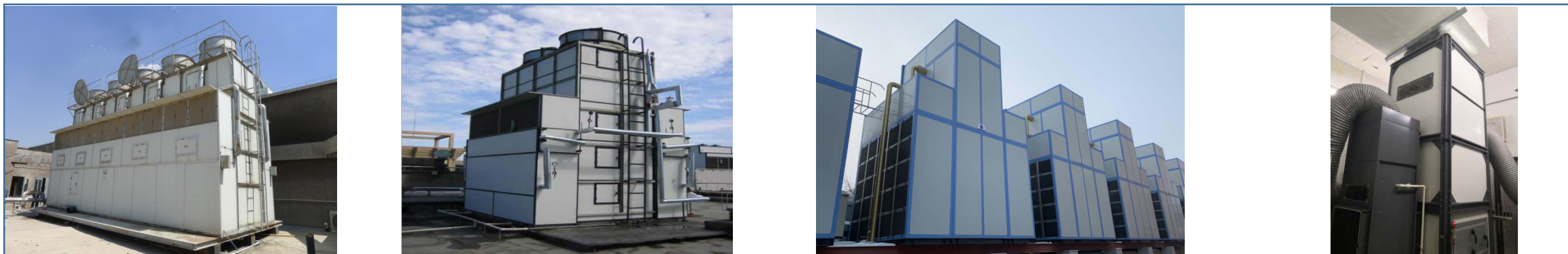
不同结构形式的蒸发冷却冷水机组（16~18℃高温冷水） THIC系统的高温冷源
