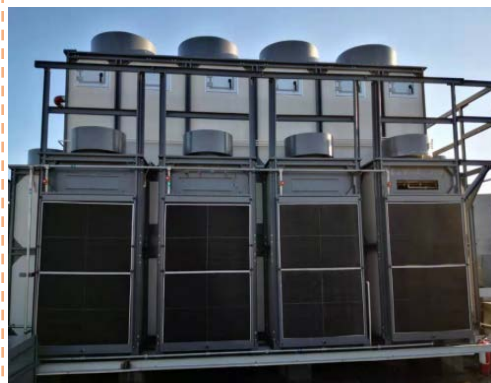
蒸发冷却冷水机组 (露点(叉流+逆流)+填料塔)
