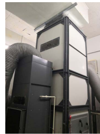
蒸发冷却冷水机组 (露点(叉流)+填料塔)
